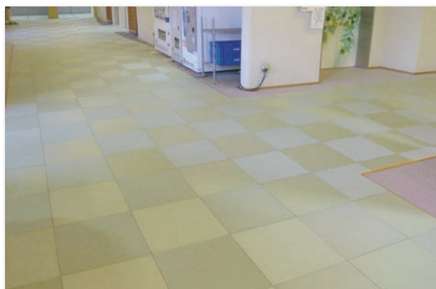
日帰り温泉 リニューアルに伴いフローリングの上に敷設しました。市松貼りにすることでおしゃれな和の空間に生まれ変わりました。
