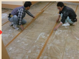
古材をきれいにはがし、押さえ 部材の受けを床に固定します。
