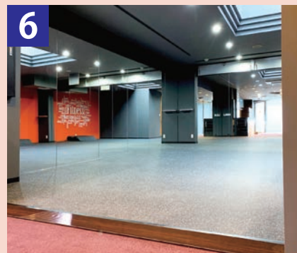
6 ジムボードとラバーマットの断面が見える側面には見切り材やスロープを入れて完成。
