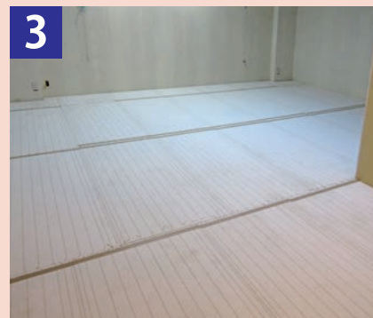
3 設置部分にジムボードを敷き詰めてください。下地への貼り付けは不要です。
