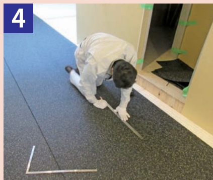
4 ラバーマットをカッターナイフで必要なサイズにカットし仮置きします。
