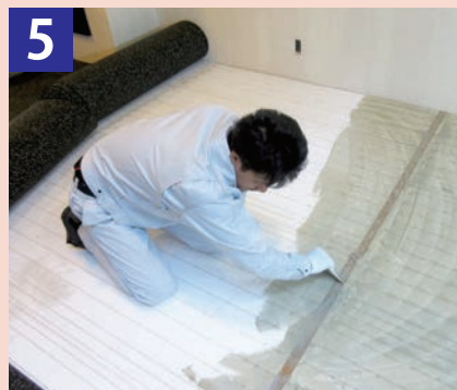
5 ウレタン系接着剤にてラバーマットを全面貼り付けしてください。
