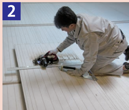
2 ジムボードを丸のこ、ノコギリ等で必要なサイズにカットしてください。
